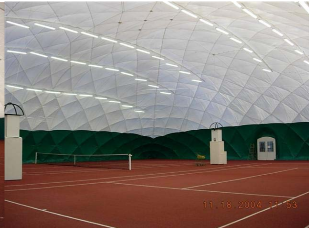
Acélsodrony hálóval erősített légsátor szerkezet
