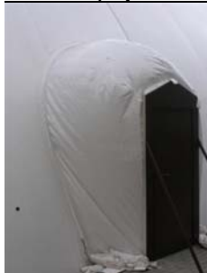
Szerelt vészkijárat acélszerkezetből
