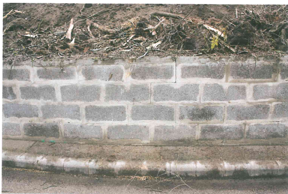
Repedések - a növényzetből jól látható, hogy a támfalat nem lehetett szögtámfalként kialakítani
