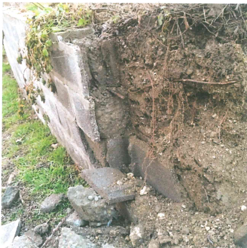
Erősen megdőlt támfal, minimális vasalással
