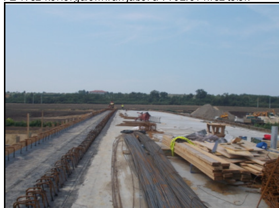
Épülő Q ági M0 híd
