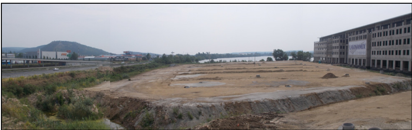
Az M1 keleti le-és felhajtója (N ág) és az épülő parkoló
