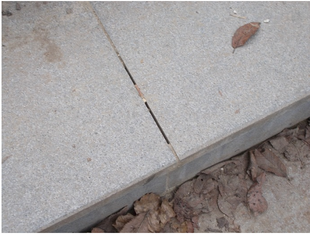
Fedkő ragasztása nem megfelelő
