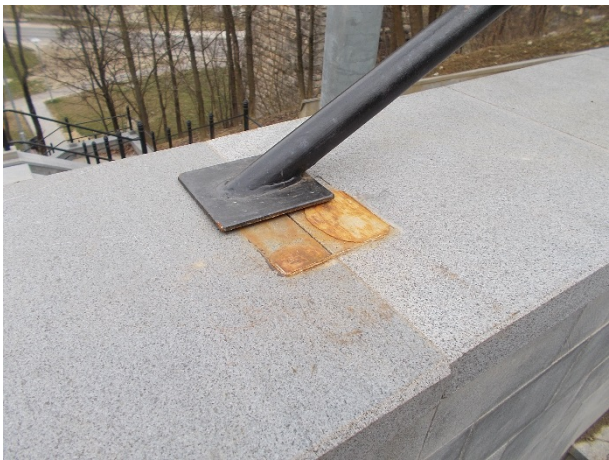
A korlát ragasztása nem megfelelő
