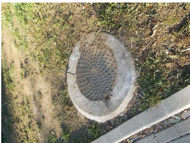
Aknafedlap beton gallérja nem megfelelő
