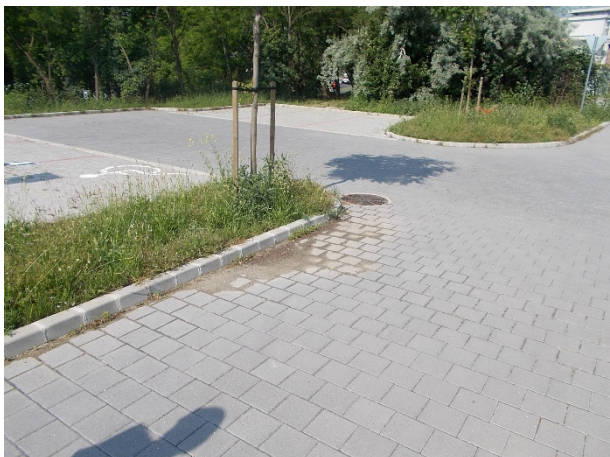
Aknafedlap beton gallérja nem megfelelő
