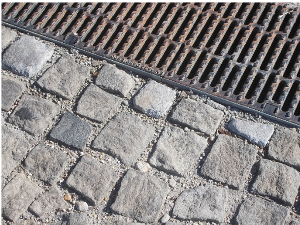
Lépcsőfok paliszád eleme kimozdult, burkolókő megsüllyedt
