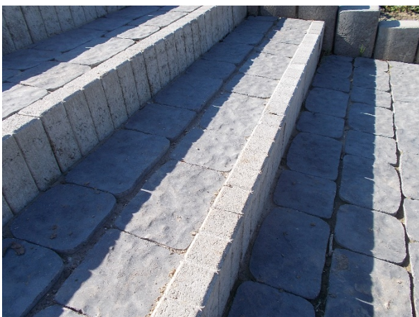
Lépcsőfok paliszád eleme kimozdult, burkolókő megsüllyedt
