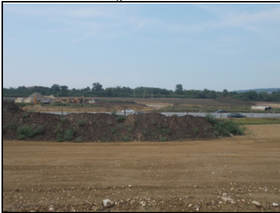
A Q ág épülő le- és felhajtó ága
