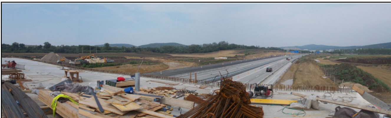
Az épülő M0 híd és a Q ág le-és felhajtója
