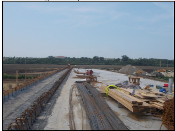
Épülő Q ági M0 híd
