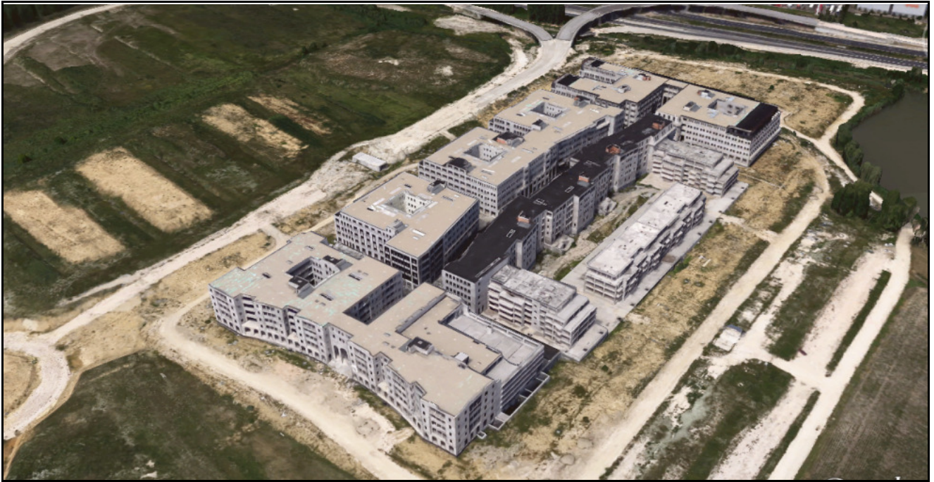
Légifelvétel a területen megépült szerkezetkész épületgyűttestről (Google Earth 3D)
