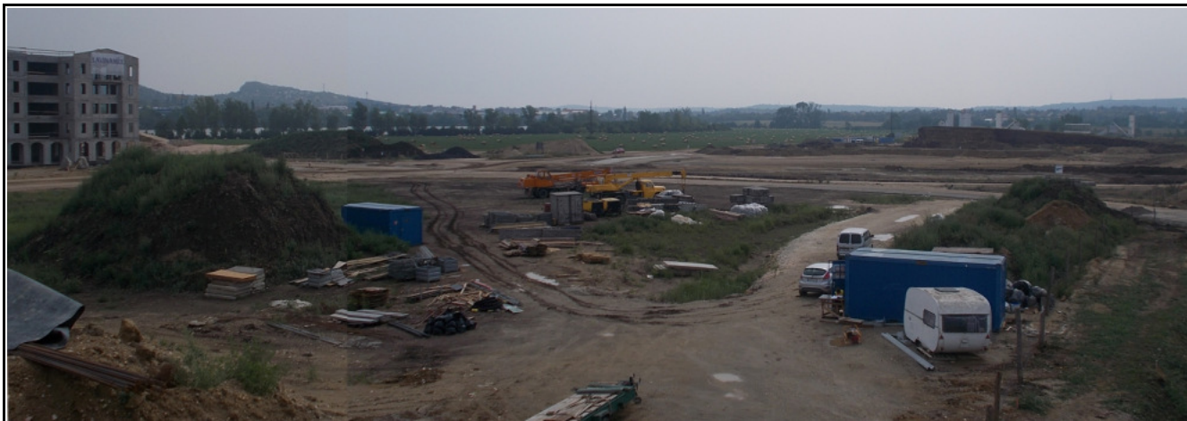
Az épülő le-és felhajtó az ÉNy- felé vezető M0-hoz (PP és SS ág)
