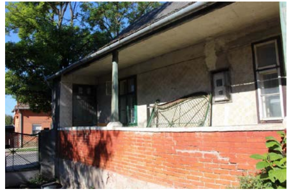
A délkeleti homlokzat (tornác) nyugati szakasza
