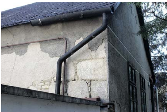
Az épület sarkán kőfalazattal erősített vegyesfal
