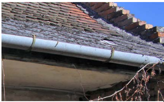
A héjazat anyagának változása és illesztése
