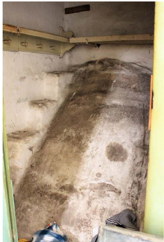
A pincelejáró boltozott lefedése felülről
