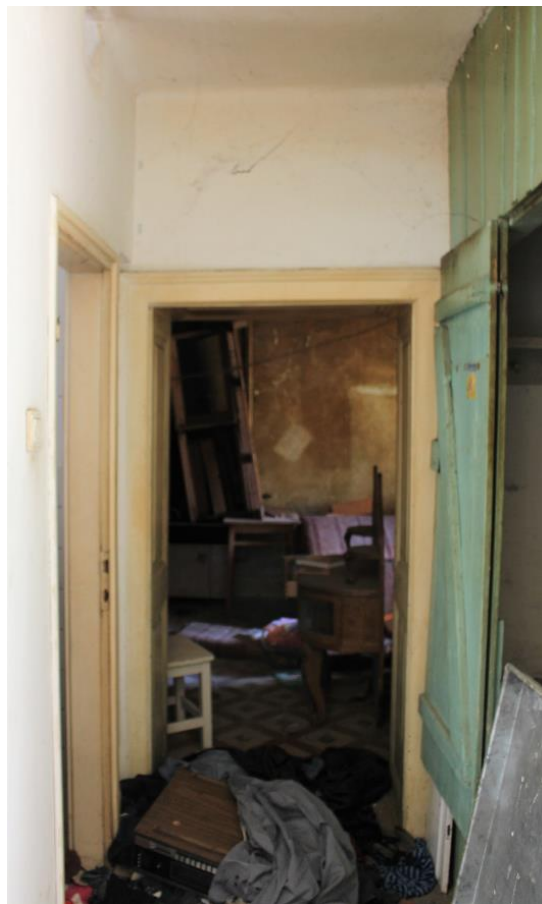
A második lakás előterének a hátsó szobába vezető szakasza, mintás terrazzólap burkolattal
