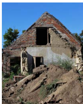
Az épületegyüttes keleti végfala a harmadik lakásegység és melléképület elbontása után
