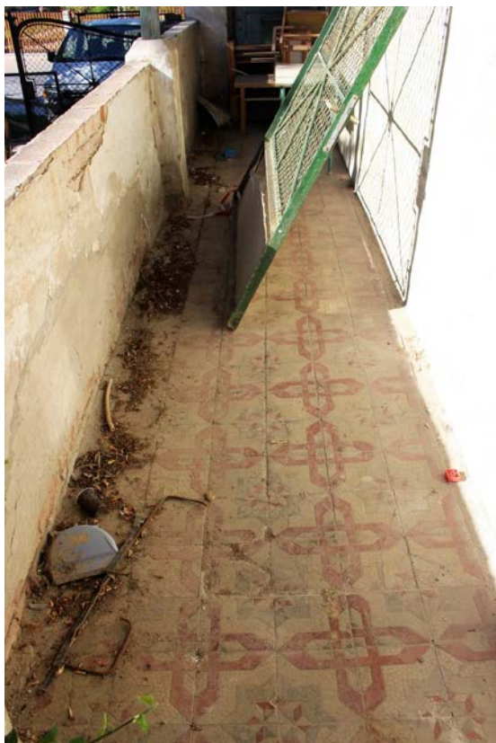
A tornác mintás terrazzo lapburkolat a tömör falazott mellvéddel
