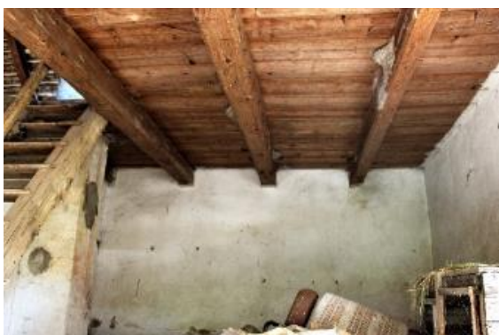
A pórfödémrel fedett gazdasági helyiség, kamra
