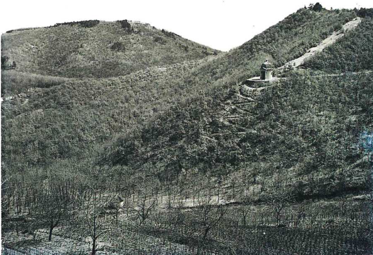
Szily-kápolna a szerpentinrel és a Keserű-kúttal, 1932 (Fortepan)
