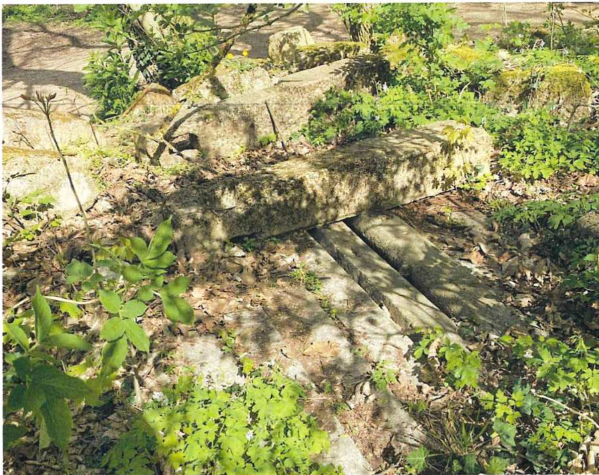
A kút nyílását balesetvédelmi szempontból ideiglenesen beton kerítés oszlopokkal fedték le, rajtuk nehezezként két villanyoszlopot tartó beton elemet helyeztek el.
