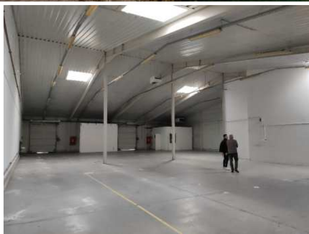
Meglévő raktárépület belső
