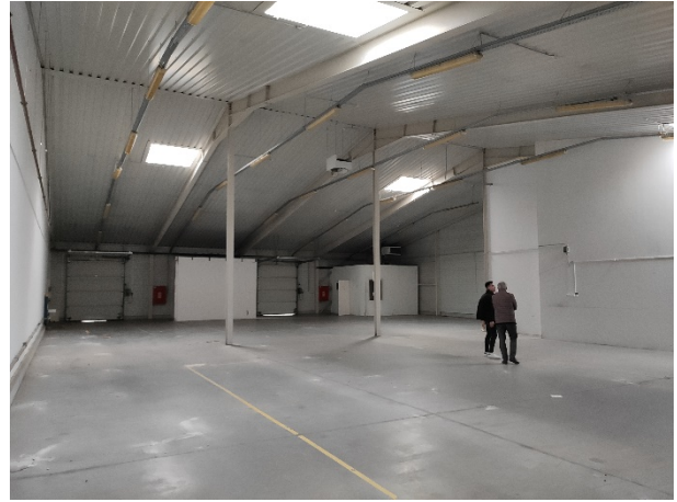
Meglévő raktárépület belső
