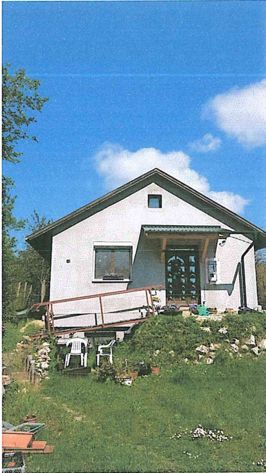
DK-i bejárati homlokzat
