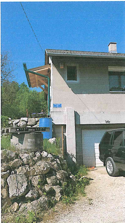
ÉK-i utcai homlokzat a pince/garázs bejárattal
