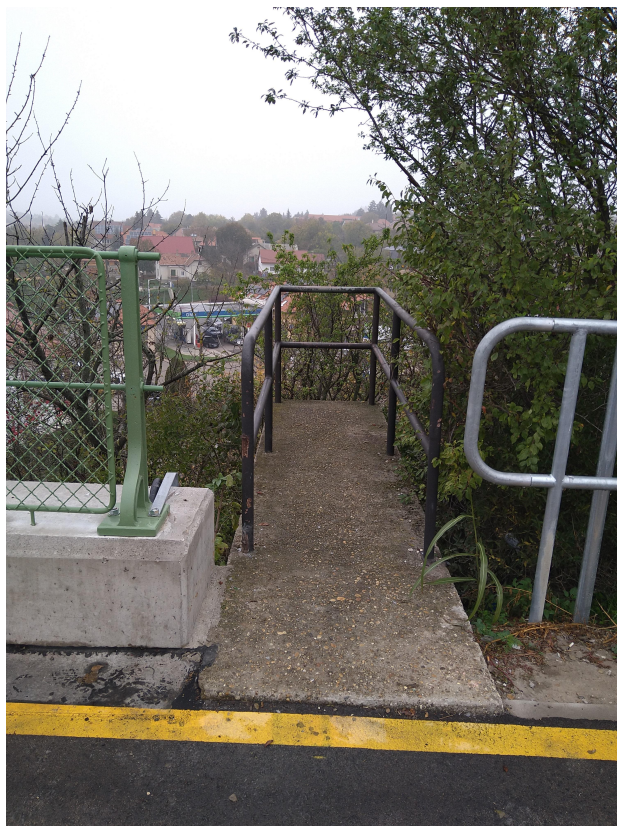
Budapest felőli oldal -hídőr állás csatlakozása
