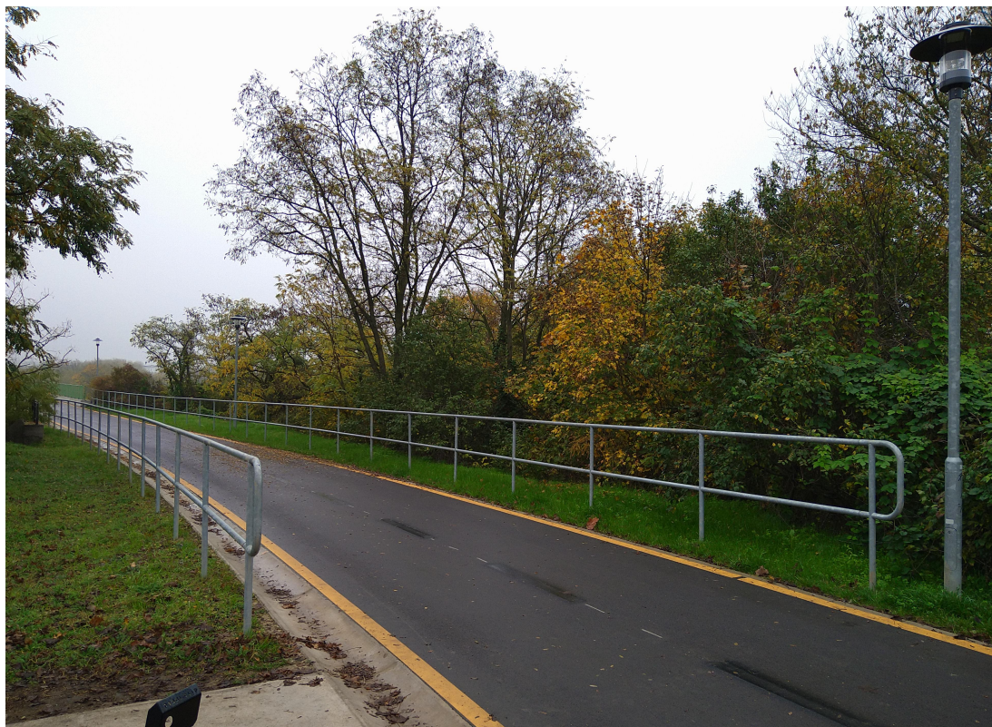
Bicske felőli oldal -balesetvédelmi 1,40 m magas kerékpár korlát
