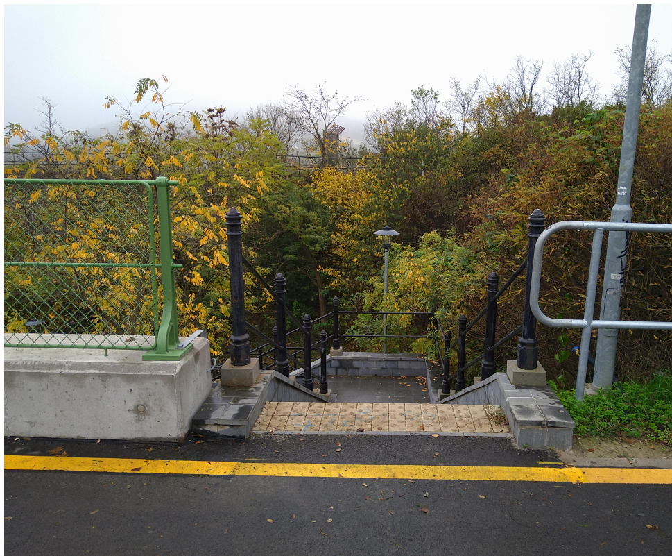
Bicske felőli oldal -lépcső csatlakozás
