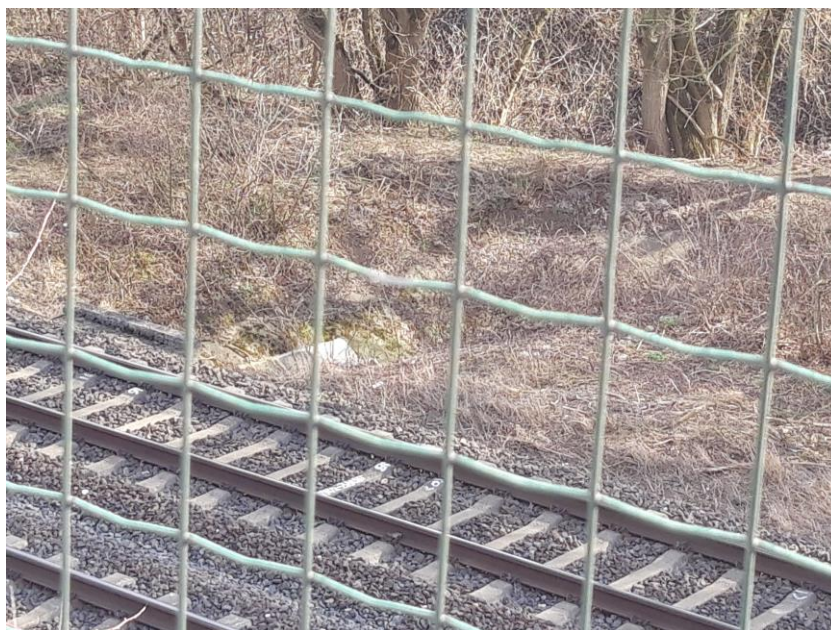
3. kép : Vasút alatti áteresz képe
