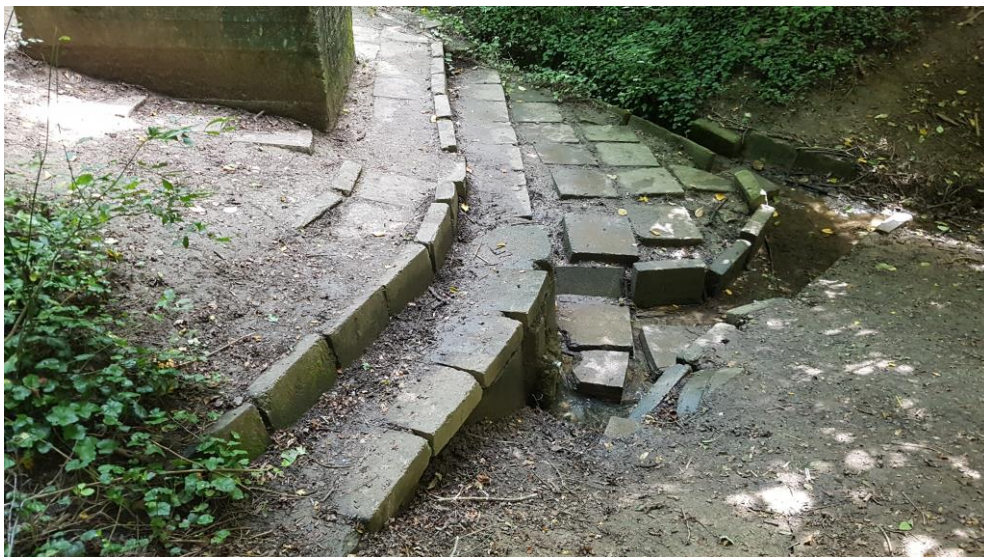
13. kép: Madár forrás romlott kialakítása
