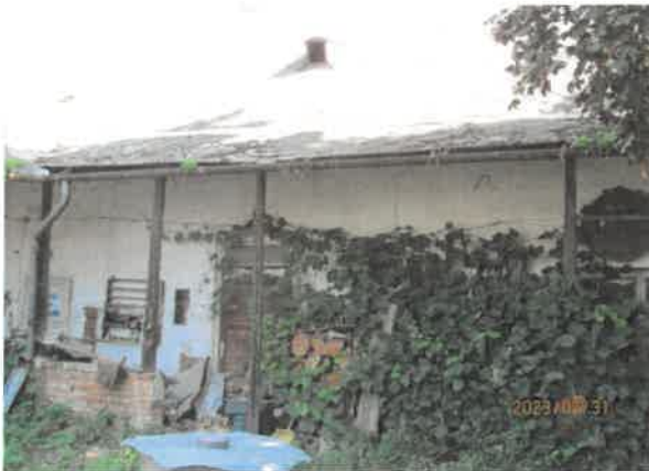
főépület az udvar felől
