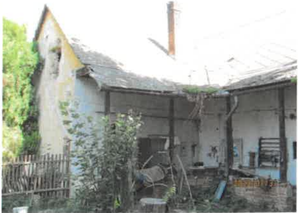
főépület az udvar felől
