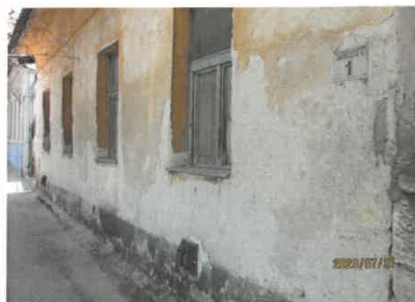
főépület utcai homlokzata
