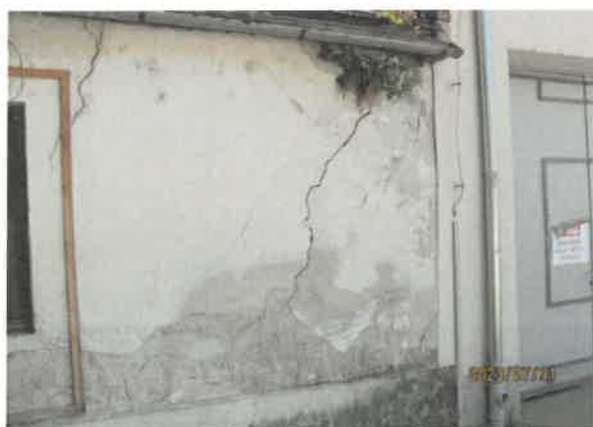
melléképület utcai homlokzat
