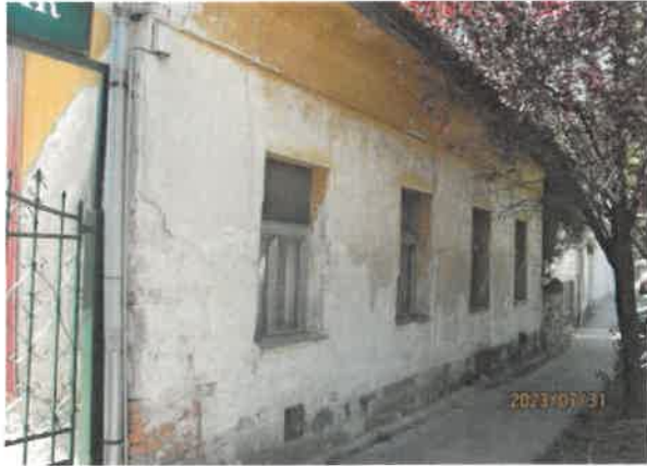
főépület utcai homlokzata
