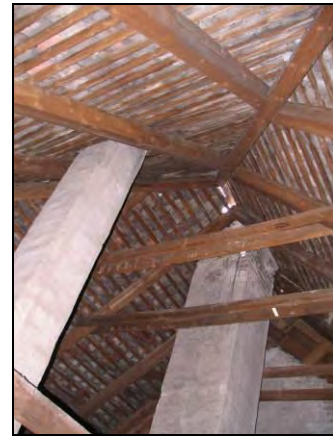
A4 kép. Lyukas gerinc, statikai problémák a 16-os főszaruállásnál
