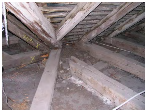
A2 kép. „Csak ilyen hosszú kötőgerendát találunk” című eset
