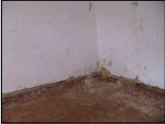
Helyiség az aljzat kiszedése után. A falak vizesek, de gombafertőzés nincs.
