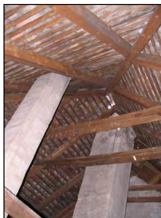
A4 kép. Lyukas gerinc, statikai problémák a 16-os főszaruállásnál
