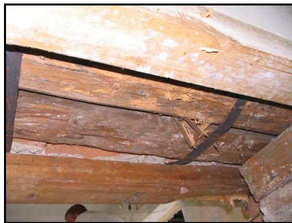
Rovarkárosodott áthidaló
