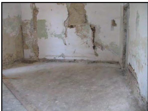
Helyiség betonozás után
