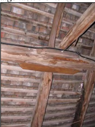
C3 kép. Nem épen így néz ki egy „szakszerű” szelemenjavítás. A következmény látható, újra megroppant a szelemen.
