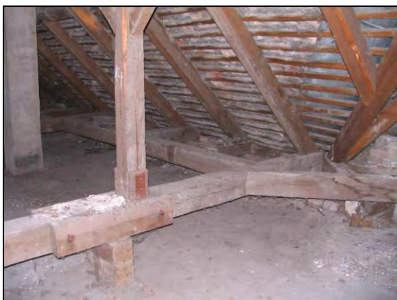
A3 kép. Tipikus kötőgerenda toldás, alátámasztás
