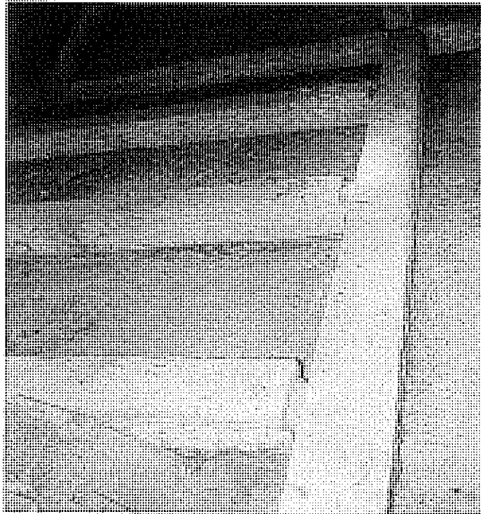
A „kicsúszott” fióktartók Az elmozdulás mintegy 3-4 cm A gerendák alsó síkja alól javaslom az agyagterítést eltávolítani, hogy a faszerkezet tudjon szellőzni
