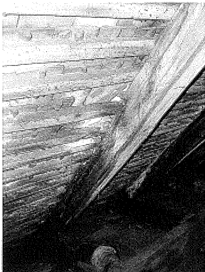
Igen nagy mértékű károsodás a szarufán és a fióktartón Több cserépléc is elkorhadt, itt várható az elemel cseréje
