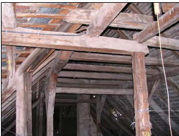
B1 kép. A „B” mező, általános képe, ahol látszik az átgondolatlan fedélszék szerkesztés
