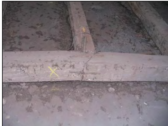
C2 kép. Az így toldott fiókváltó pont azt funkcióját vesztí el, amiért ide berakták
