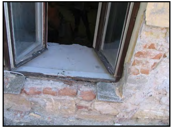
Elkorhadt ablak alsó vízszintes tokszára
