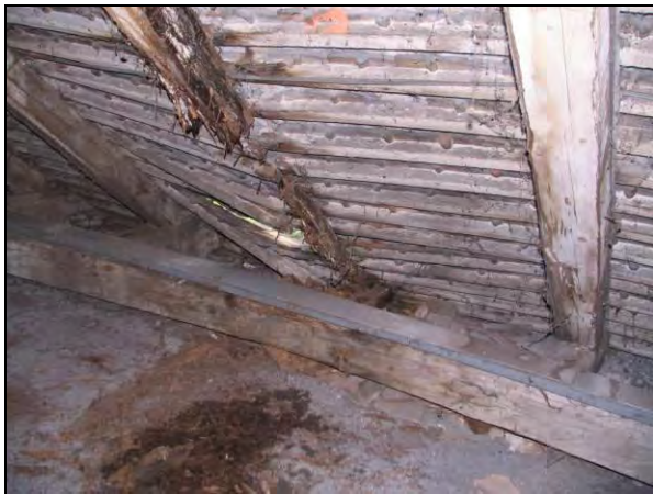
A3 kép. Bármely hihetetlen, de az a görbült gerenda fiókváltó akart volna lenni. Előtte vízfolt.
