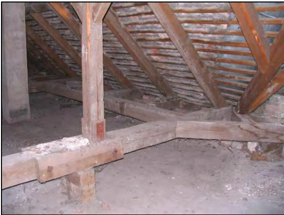
A3 kép. Tipikus kötőgerenda toldás, alátámasztás
