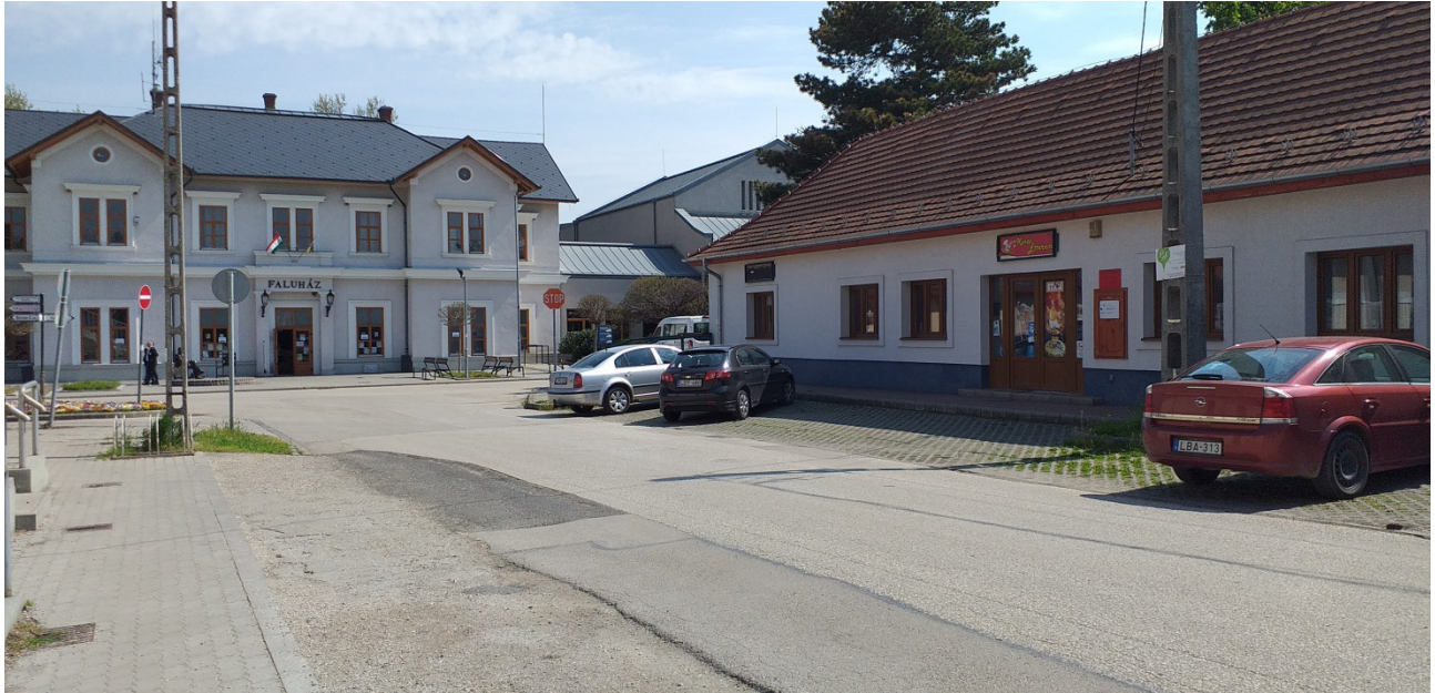
10. kép: Vasút utca – Baross Gábor utca – Viadukt utca csomópont
