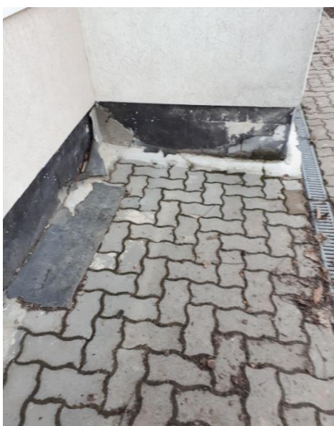
2004-ben készült épület lábazata a felső szinten, sérült a járdával megsüllyedt és letépte a szigetelést. Befelé az épület felé leejt.
