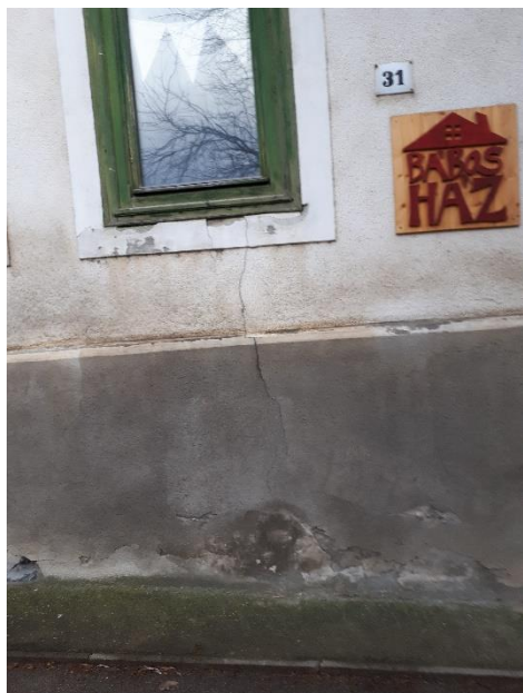
Az utcai homlokzaton nedvesedés látható.
