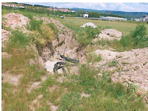
34. ábra: A 7702/45-ös hrsz.-ú ingatlanon keresztül húzódó, egy szakaszon feltárt elektromos földkábel
