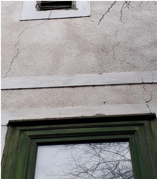
Megjelentek a szerkezeti repedések a nyílászárók sarkinál.
