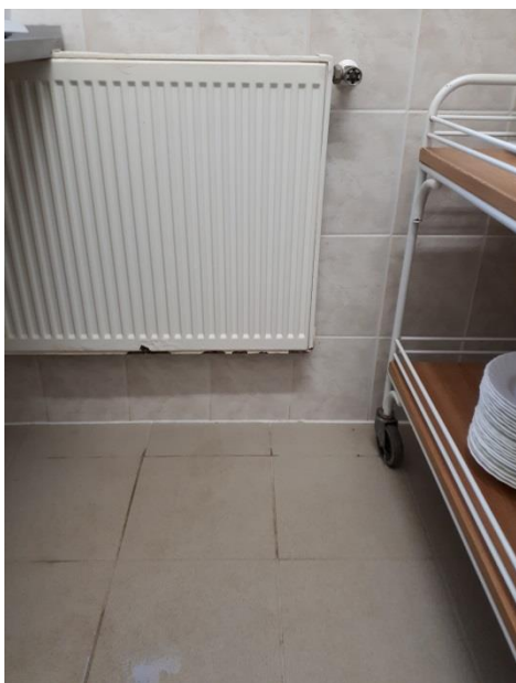
A vizes helyiségekben a radiátorok rozsdásodnak.
