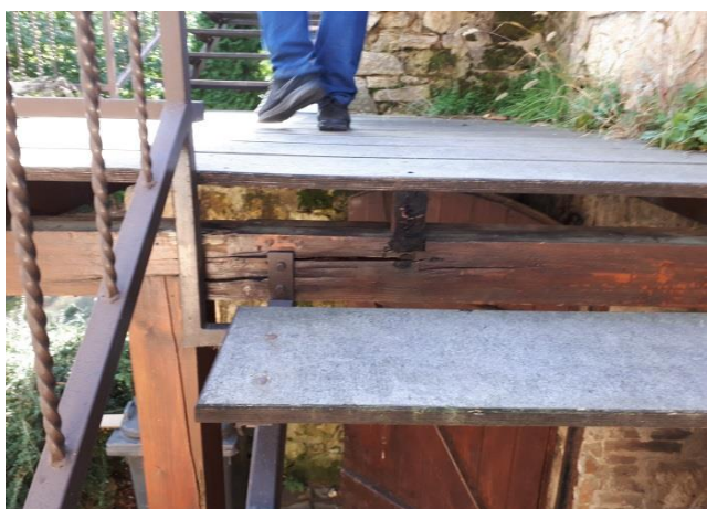
A lépcső acél tartószerkezete az elkorhadt faszerkezethez csatlakozik.
