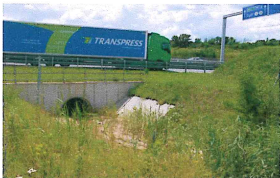
31. ábra: Az M0 autópálya alatt átvezetett csőátereszt és az 1. sz. időszakos vízfolyás sávja
