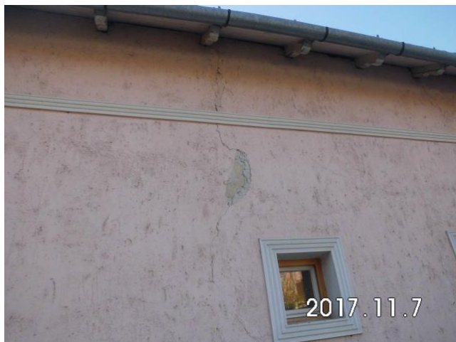
Az épület falazatán szerkezeti repedések találhatóak.
