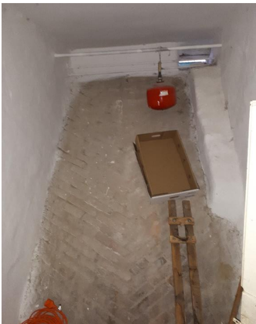
Fűtetlen térbe átmenő szigeteteletlen fűtéseső ami fagyveszélyes.
