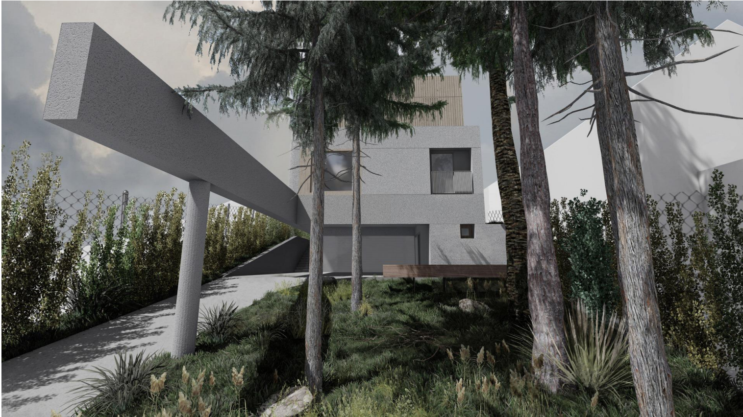
Az épület ÉK-i nézete a gépkocsitároló és bejárat visszahúzott frontja előtérben az épület ÉK-i tömegét tartó nagyméretű gerendával.
