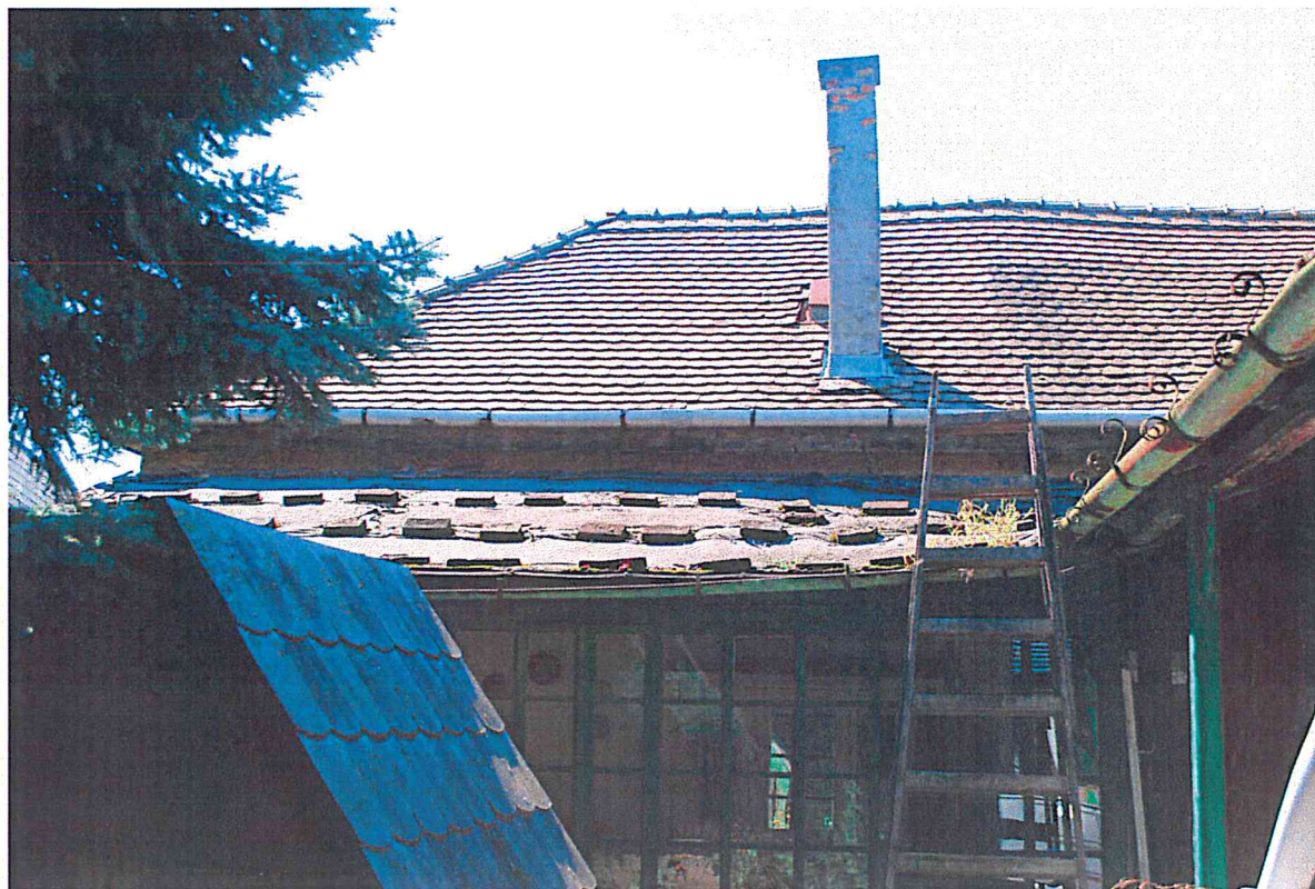
A veranda összképe északkelet felől
