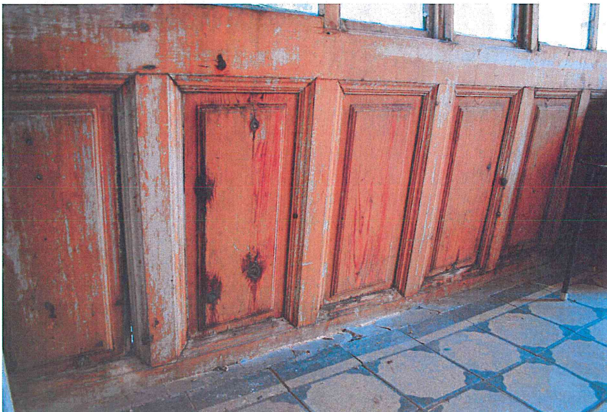
A deformálódott, váztablázatos mellvéd részlete
