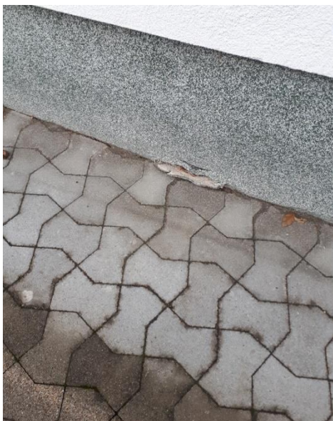
Térkő lábazat mozgása elősegíti a lábazat sérüléseit.
