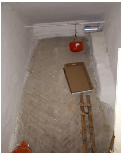
Fűtetlen térbe átmenő szigeteteletlen fűtéseső ami fagyveszélyes.
