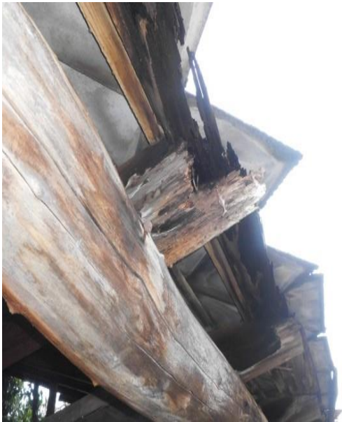
Fészer szarufa végei a tetőhéjázat hiányossága miatt elkorhadt.
