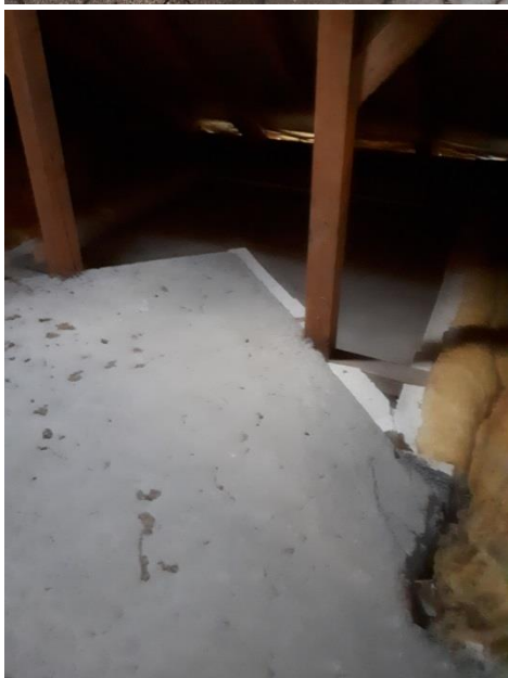
A padlástérben a hőszigetelés sok helyen hiányos, mállik, porlad
