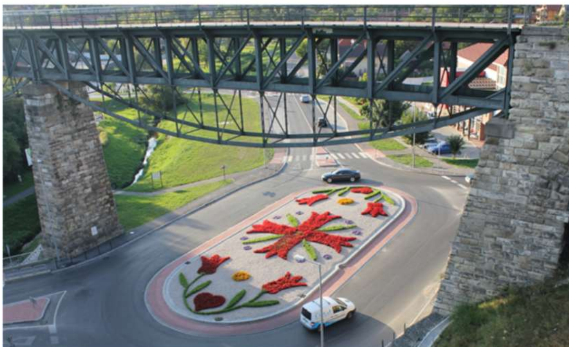
A kuriózum számba menő alsó parabola ívű megerősítés 1941-ben készült el.
