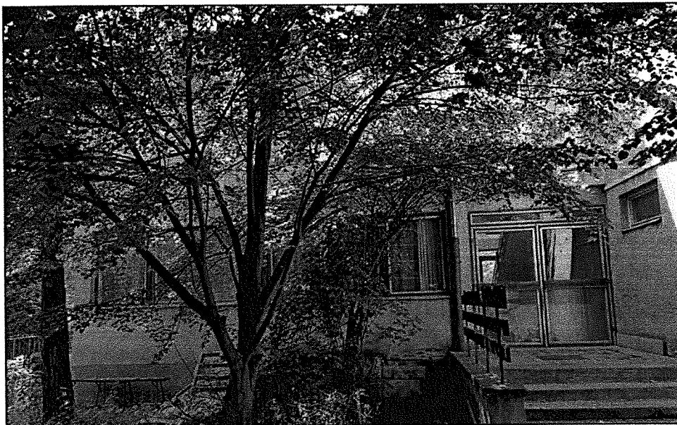
11. számú kép. Délkeleti oldali, hátsó homlokzat, oldalsó épülettömb, hátsó oldali lépcsőházi nyaktag és előlépcső.
