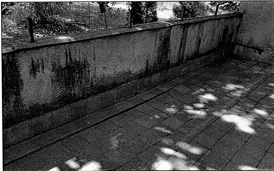
41. számú kép. DK-i oldal, belső helyzetű épülettömb erkélye. Zárt mellvédfallal rendelkező erkélyt alakítottak ki. A vízvezetés nem működik, az erkély egy „vízgyűjtő medence”. Oldalfalán kúszik fel a moha, burkolata megsüllyedt.
